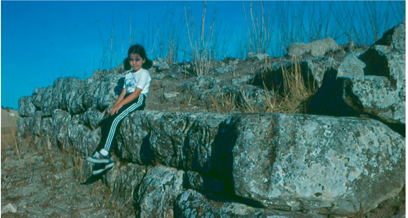
Esquina NW.y muro N. 1980
