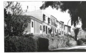
Obra de remodelación en la Avda. De Fleming. Información en Pág. 4
