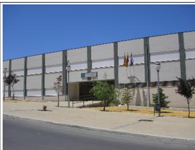
Fotografía nº 12. Nuevo Instituto de Secundaria.
